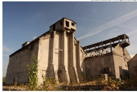
RUINY CEMENTOWNI SZCZAKOWA SZCZAKOWA CEMENT WORKS RUINS
